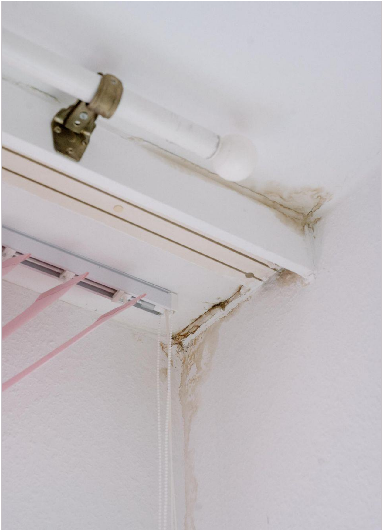
Wasserflecken auf der Wand in der Wohnung von Arshed Hashimi © Aliona Kardash / stern
